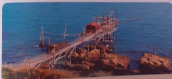
Il trabucco è un'imponente costruzione in legno formata da una piattaforma protesa sul mare. Grazie a delle lunghe "antenne", permette ai pescatori di pescare senza inoltrarsi in mare con le imbarcazioni.
